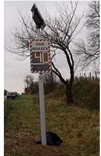
Ex : Radar pédagogique alimenté par mât de production solaire Energiedouce dans le Nord
